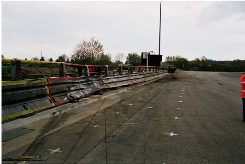
Bild 35: Schutzeinrichtung nach der Prüfung und Fahrzeug in Endstellung
