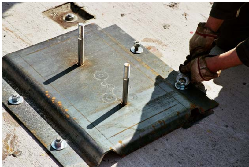
Bild 2: Detail: Verankerung der Fußplatte des Systems
