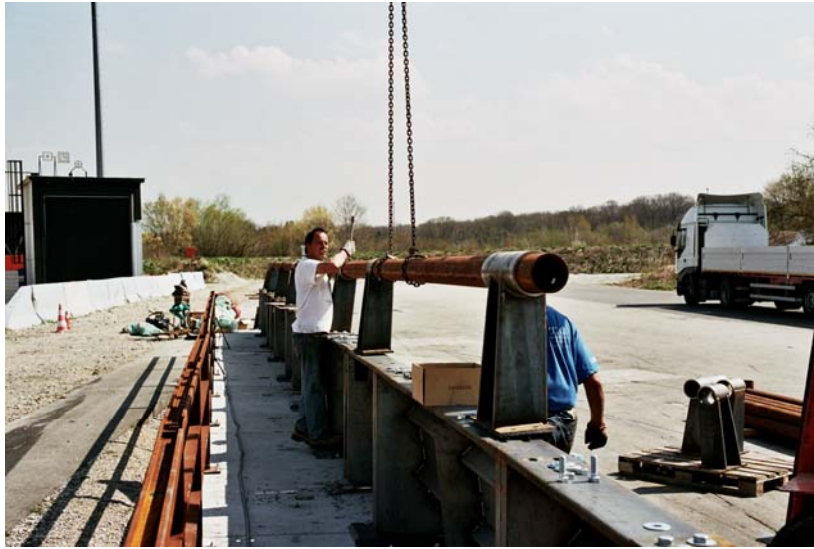
Bild 7: Rohrkonstruktion in Längs- richtung
