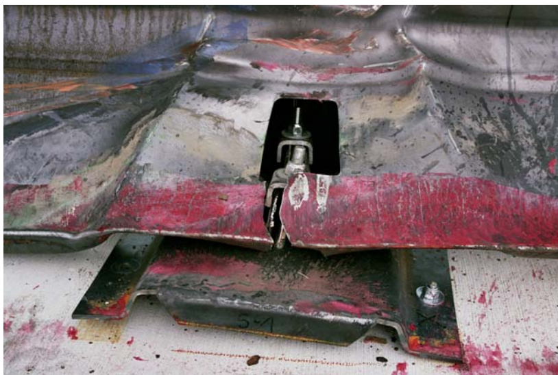
Bild 45: Schäden an der Verankerung und Fußplatte
