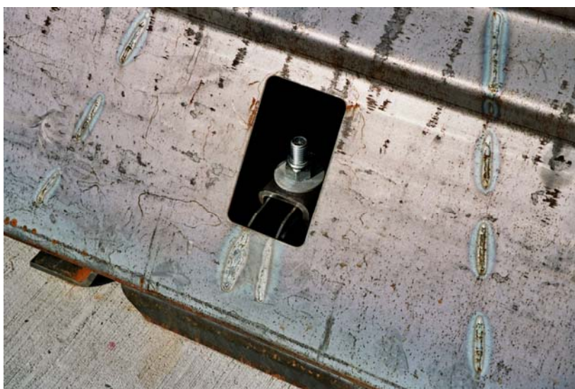
Bild 6: Verbindung des Elementes mit der Fußplatte
