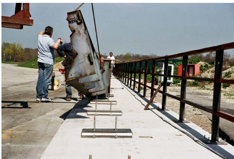
Bild 3: Aufsetzen eines Elementes auf der Brückenkappe
