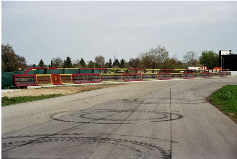
Bild 10: Gesamtansicht der Schutz- einrichtung vor der Prüfung
