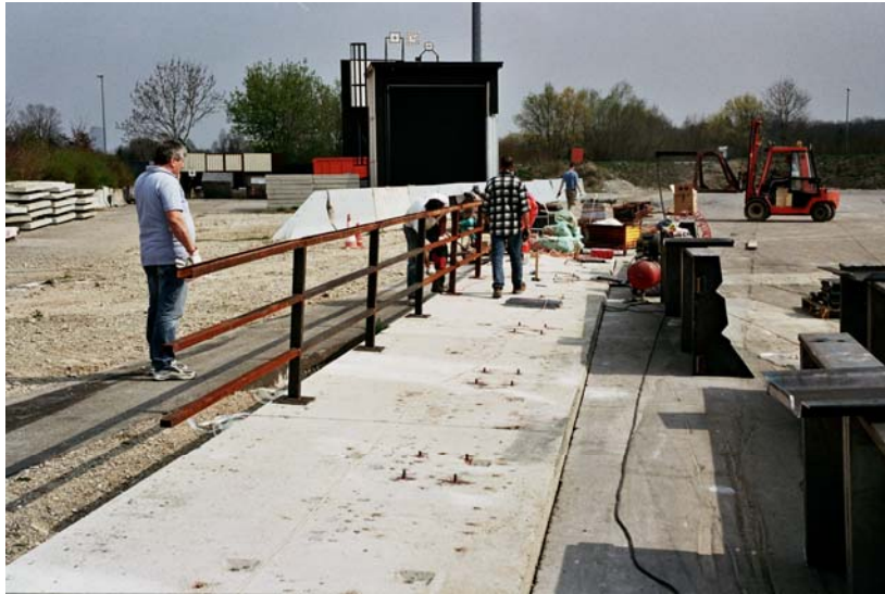
Bild 1: Verbundanker in der Brückenkappe und Monta- ge Geländer auf der Brü- ckenkappe
