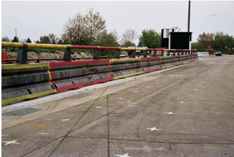
Bild 30: Schutzeinrichtung nach der Prüfung und Fahrzeug in Endstellung
