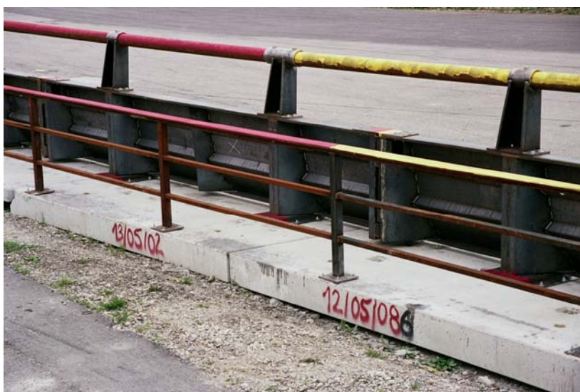
Bild 9: Schutzeinrichtung und Geländer (Rückansicht)
