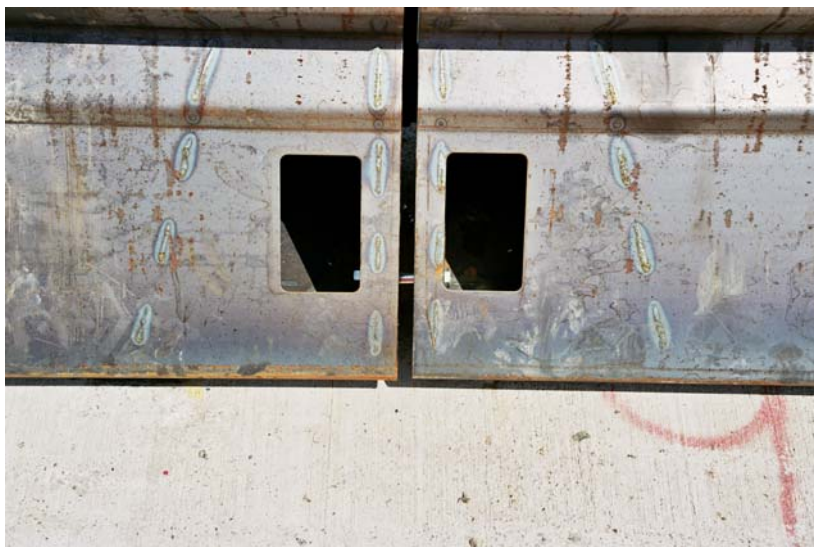
Bild 5: Verbindung der Elemente (Vorderseite)
