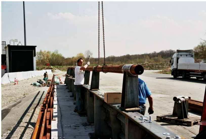
Bild 7: Rohrkonstruktion in Längs- richtung
