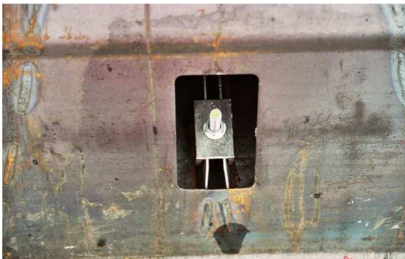
Bild 6: Befestigung eines Elementes mit dem Verbundanker
