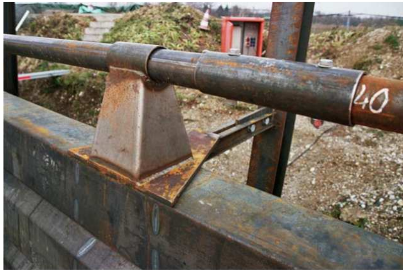
Bild 7: Führung der Rohrkonstruktion auf dem Element und Verbindungsstufe
