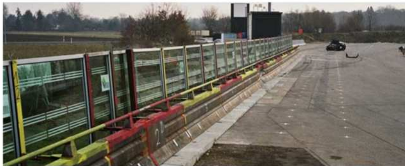
Bild 29: Schutzeinrichtung nach der Prüfung mit Fahrzeug- endposition
