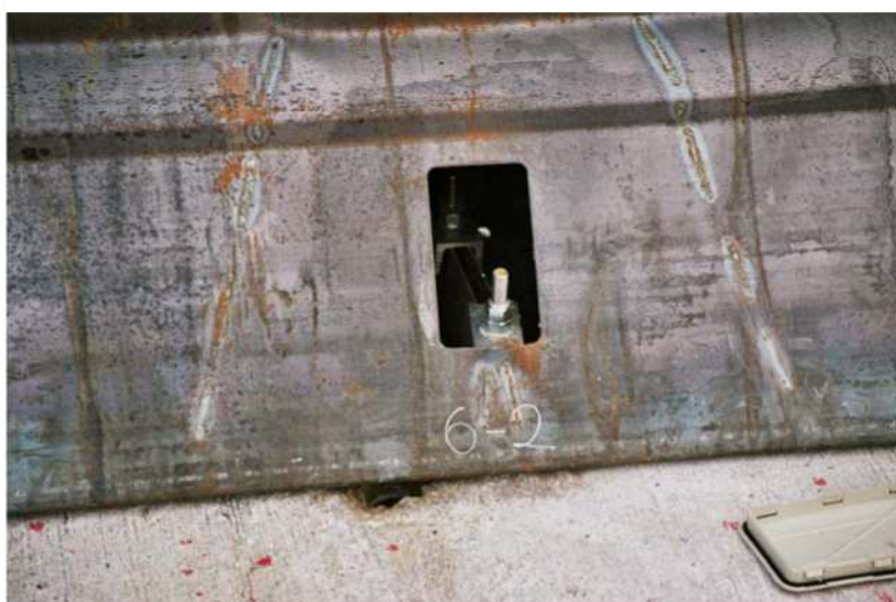
Bild 37: Verschiebung der Verankerung 6-2
