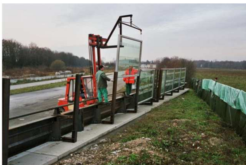
Bild 9: Einbau der Lärmschutzelemente
